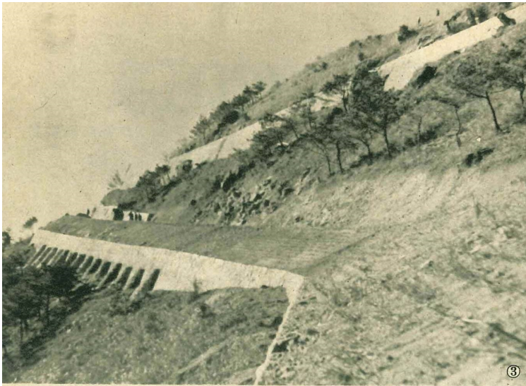
③山上に資材を運ぶにはまず道路を造らねばならない。栗ヶ嶽の道路工事は岩盤が多く、また豪雨に、颱風になやませられ、困難を極めた難工事であつたが、写真のように立派な道路が完成した。
