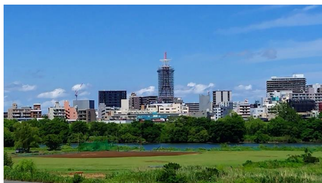
松戸無線中継所：鉄塔塗装中
