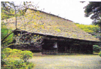
屋根の妻側にある火灯窓に注目
